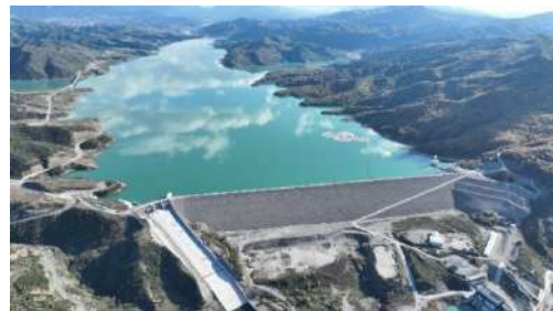
Figura 1-1 Hidrocentrali i Banjës
